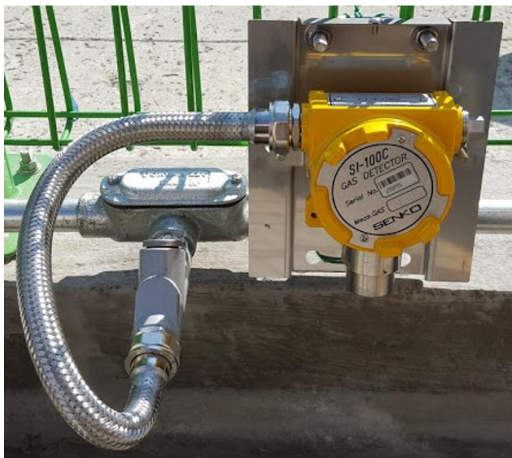
(Montaż na otwartej przestrzeni)
